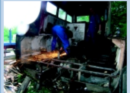
... entkernen und zerlegen, ...
